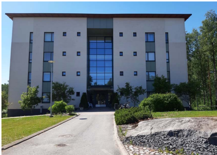
Kuva 23 yllä: Voisalmentie 10:n julkisivu itään ja sisäänkäynti.
