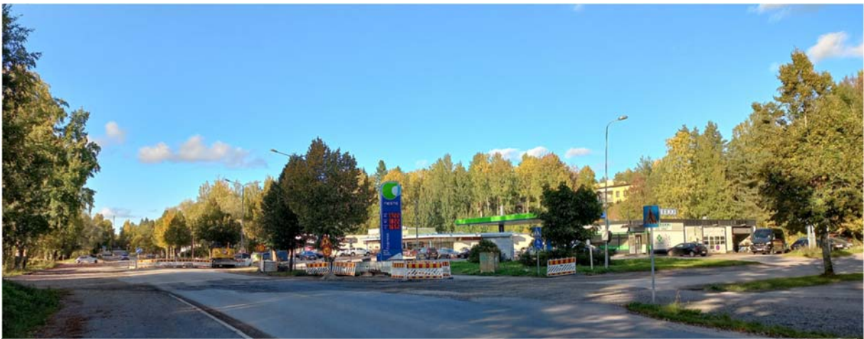
Kuva 29: Näkymä Voisalmentieltä pohjoiseen, oikealla Voisalmen aluekeskuksen liikerakennuksia, taustalla rinteeseen rakentuneita neljäkerroksisia asuinkerrostaloja ja oikealla Kivisalmentie.
