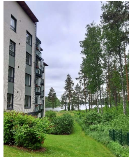
Kuva 22: As Oy Omenatarhan porrastuva julkisivu länteen.
