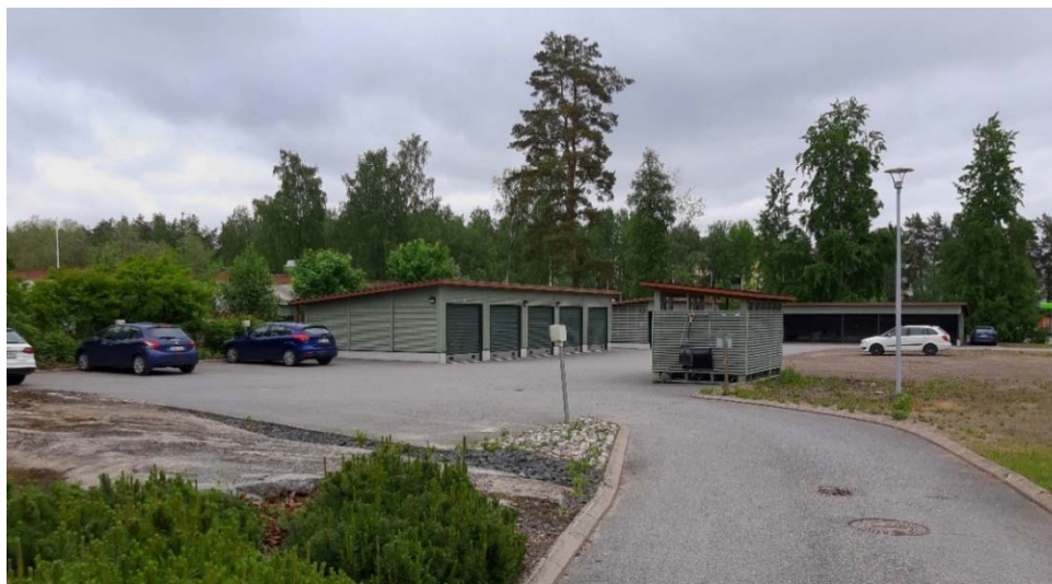
Kuva 21: Voisalmentie 10:ssä sijaitsevan Asunto Oy Lappeenrannan Omenatarhan pysäköintialue ja autokatokset, vasemmalla Voisalmen päiväkodin.
